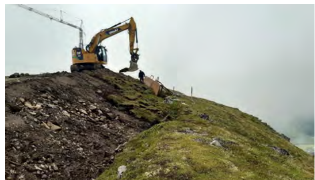
Abb. 6 Aufbringung der Vegetationssoden auf der Dammböschung des Speicherteiches mittels Bagger
