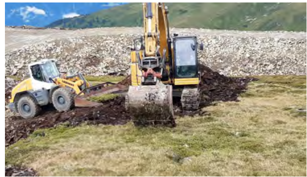
Abb. 4 Bergung und Abtransport von Vegetationssoden mittels Bagger
